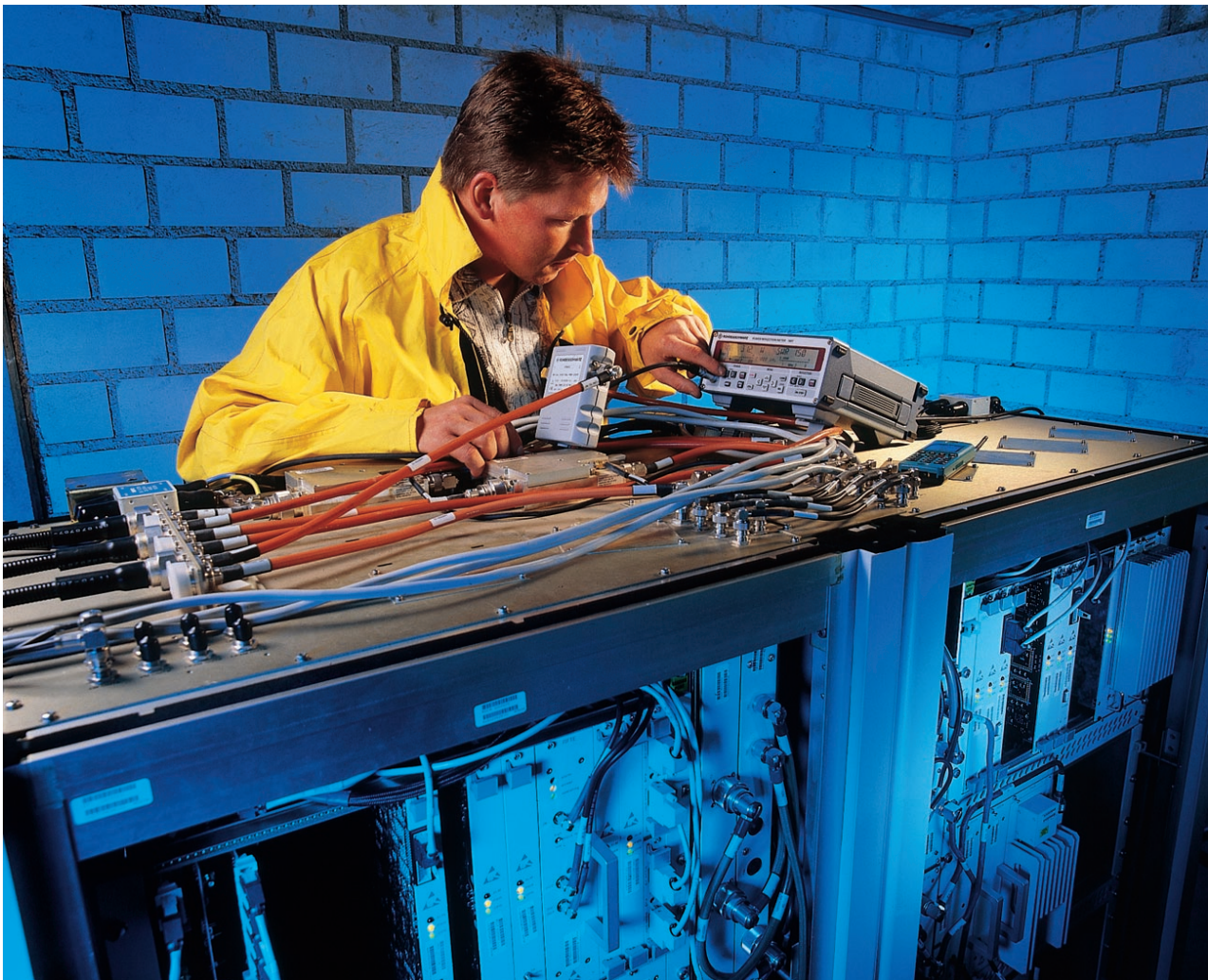
NRT bei der Installation einer Mobilfunk-Basisstation (Foto 42667)
